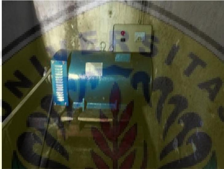
Gambar 1. Pemasangan generator sinkron 3000W dan stabilator tegangan
