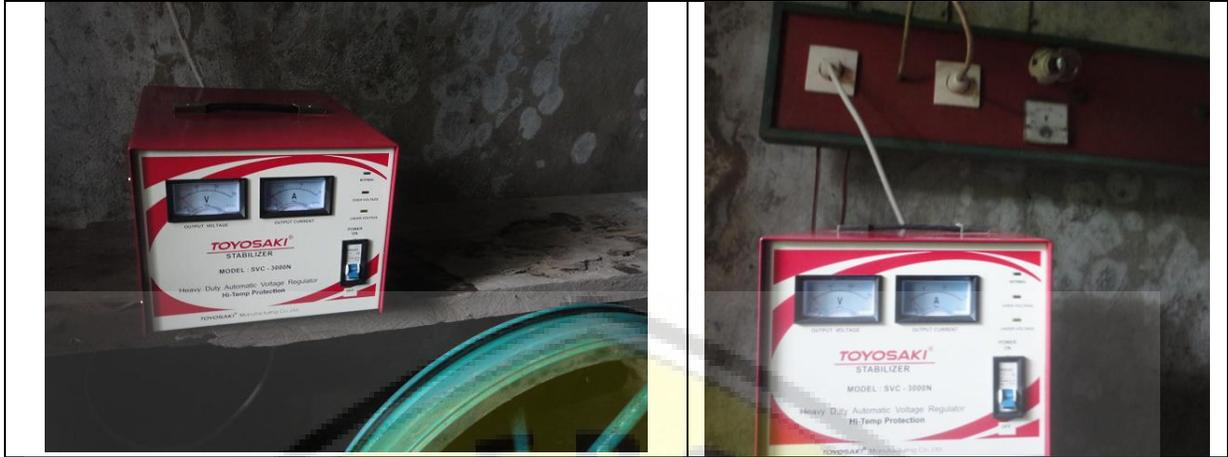
Gambar 2. Pemasangan penstabil tegangan
