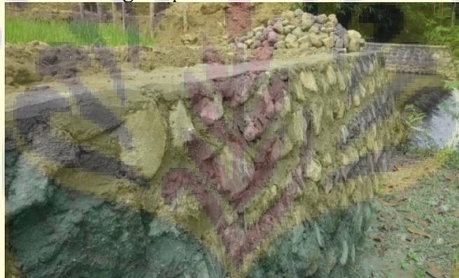
Gambar 3. Penguatan tanggul dan penambalan saluran yang bocor
