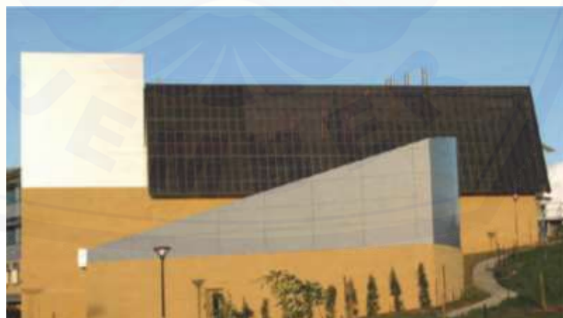
Gambar 2.12 Panel STI DSSC sebesar 200 m 2 dipasang di Newcastle (Australia) modul DSSC komersial pertama (Jasim, 2011)
