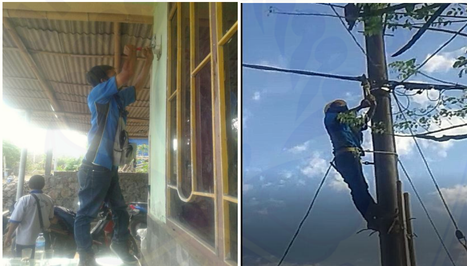
Gambar 7. Proses Penambahan Daya Listrik Di Rumah Mitra Sebagai Sumber Listrik Dalam Kegiatan Produksi Yang Dilakukan Oleh Mitra (Sumber: Dokumentasi Lapangan, 2020)
