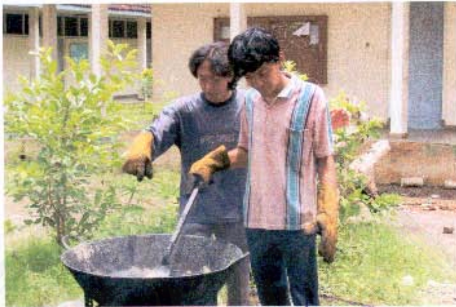
Foto 1. Proses Mencampur/Menggoreng Aspal
