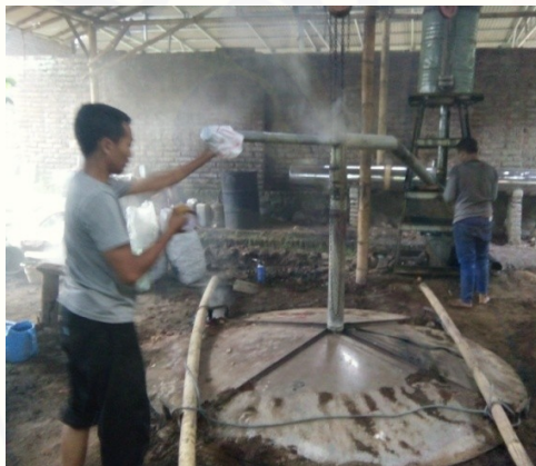
Pemasangan tutup tungku pembakaran
