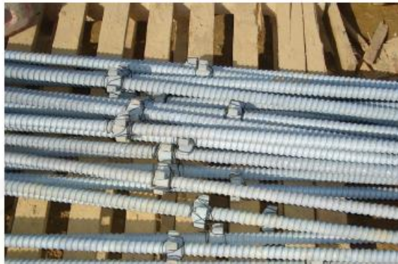
Gambar 2.11 Penengah yang terpasang pada batang baja ulir.
