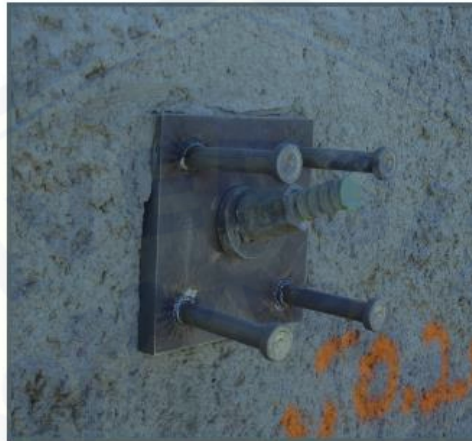
Gambar 2.10 Foto Batang baja dengan plate , washer , dan nut
