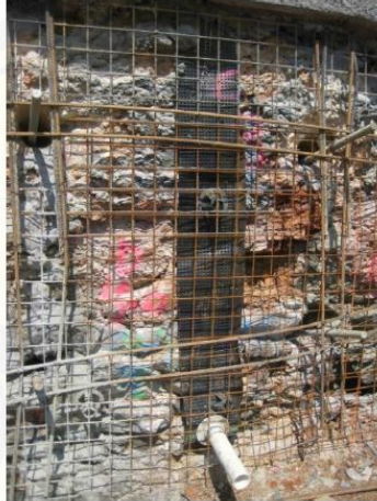
Gambar 2.12 Gambar drainase pada dinding sebelum penyemprotan Shotcrete .
