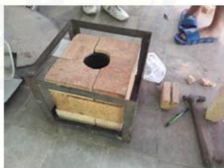
Proses pemasangan dapur pada rangka
