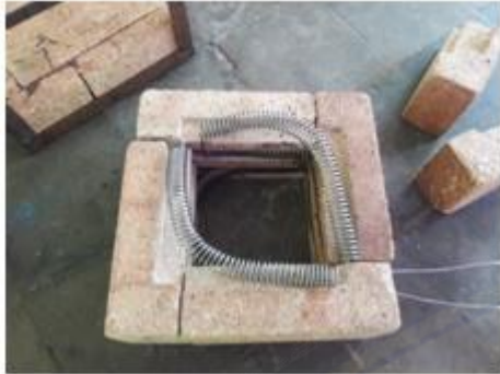
Pemasangan coil pada dinding dapur pengecoran
