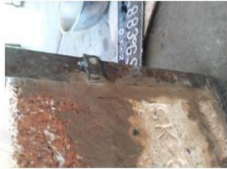
Proses pengeleman dinding yang berlubang
