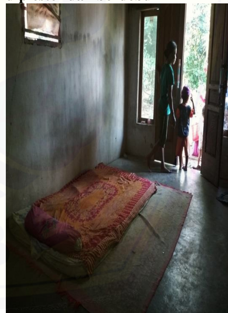
l. Kondisi ruang keluarga dengan jendela mati
