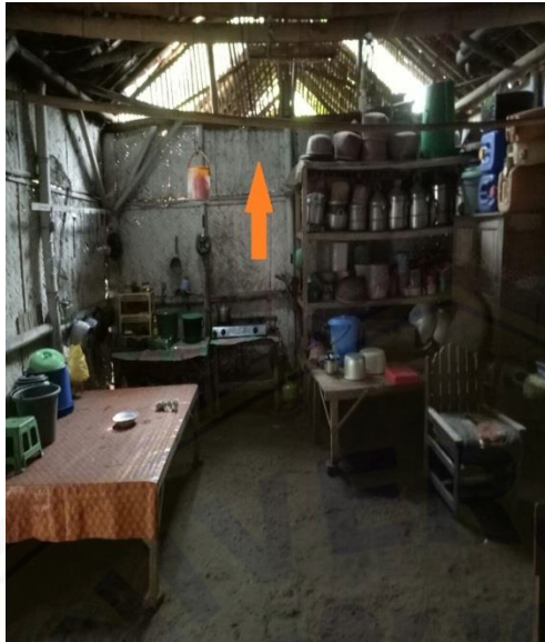
e.Kondisi dapur dengan memiliki lubang asap dan ventilasi kurang serta berlantaikan tanah
