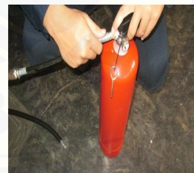
Gambar 10. Me masang selang nozzle pada tabung APAR
