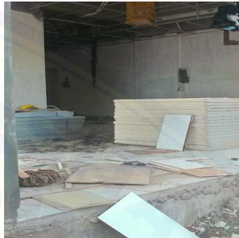
Pekerjaan elektrikal lantai 1
