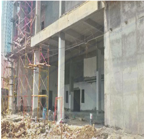
Pemasangan alat perancah
