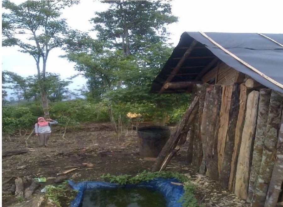
Penampungan Air Hujan
