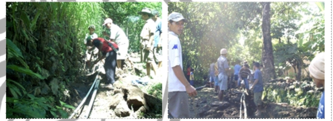
Gambar 5. Pembangunan Fisik Perpipaan
