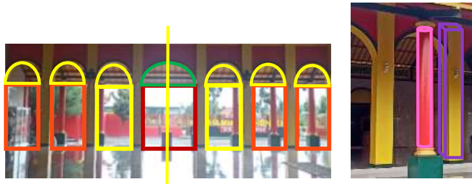
Gambar 4. 2 Tiang Penyangga Masjid
