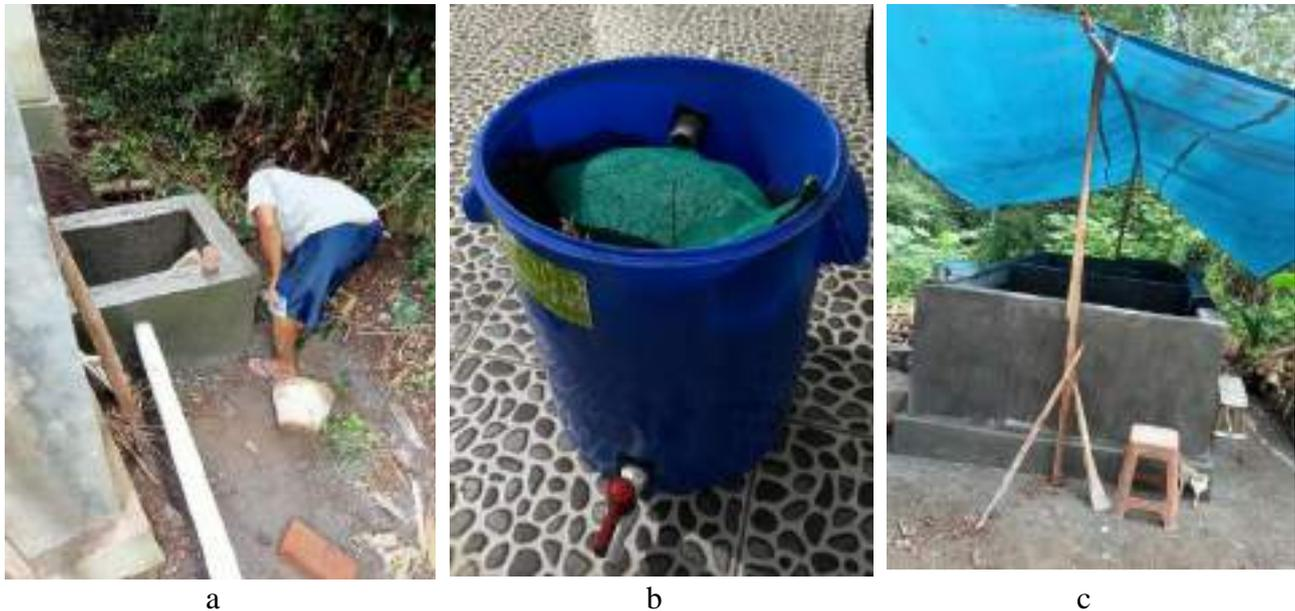
Gambar 12. Rangkaian alat pengolahan limbah cair tempe (a. Bak penampungan; b. Bak filtrasi; c. Bak penampung air jernih)
