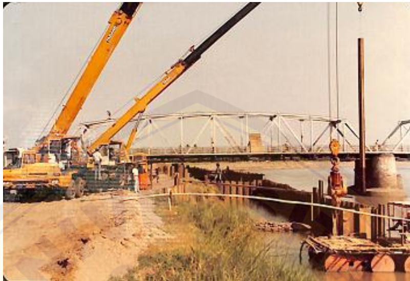
Gambar 3.1. Proses Pembangunan Bendungan Bening
