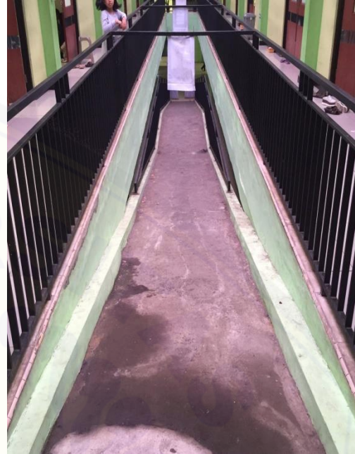
Kondisi jalan landai/ramp
