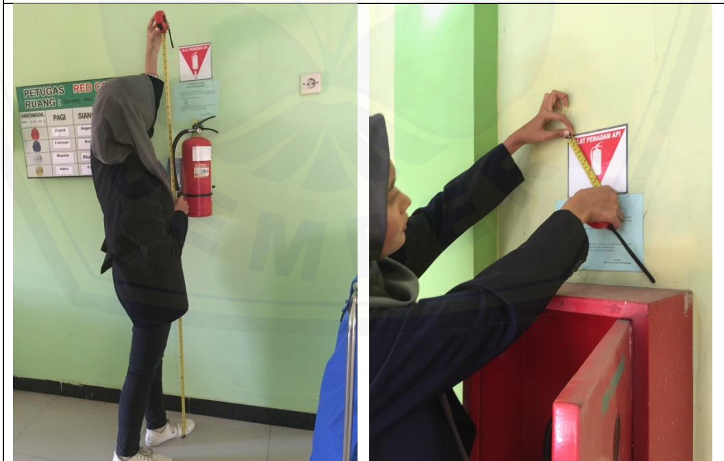
Pengukuran tinggi pemberian tanda pemasangan APAR
