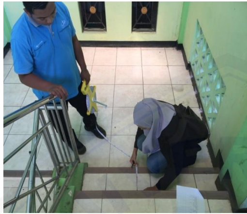
Pengukuran lebar pijakan tangga darurat
